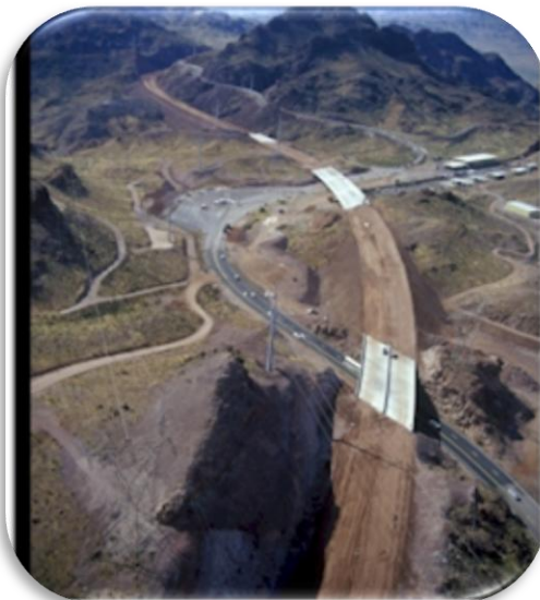
ĐƯỜNG VÔ CẦU PHÍA NEVADA (hình trên)
