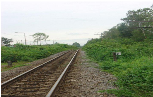
Một đoạn đường sắt điển-hình tại Việt-Nam ngày nay (2008), với trà-vẹt bê-tông cốt-sắt 2 cục.
