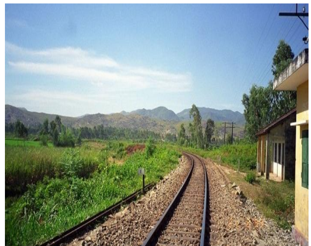
Nhà ga nhỏ trên đoạn đường-sắt Việt-Lào
