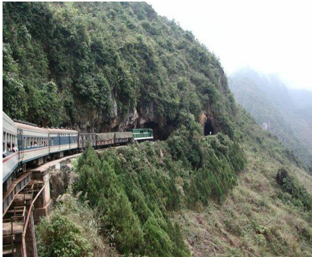
Một đoạn đường Hải-Phòng/Vân-Nam, trên lãnh-thổ Trung-Hoa. Cầu cao và hầm kế-tiếp liên-tục.
