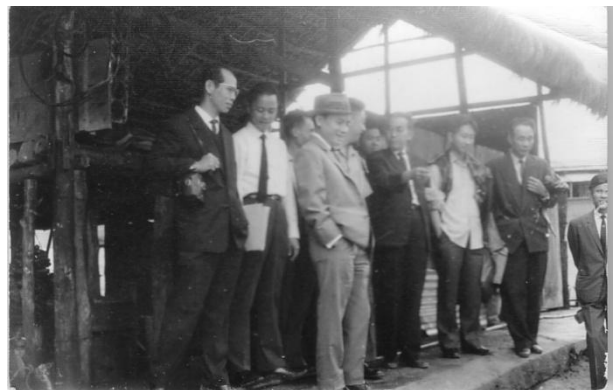
Phái đoàn Công chánh đi tham quan công trường đà tiền áp Quảng Ngãi. (Từ phải Ngô Trọng Anh, Hồ Đăng Lễ, Lê Thành Trinh, Bùi Hữu Tuấn, Trần Ngọc Oành, X., X., Dương Kích Nhưỡng, X., và Tôn Thất Toại.
