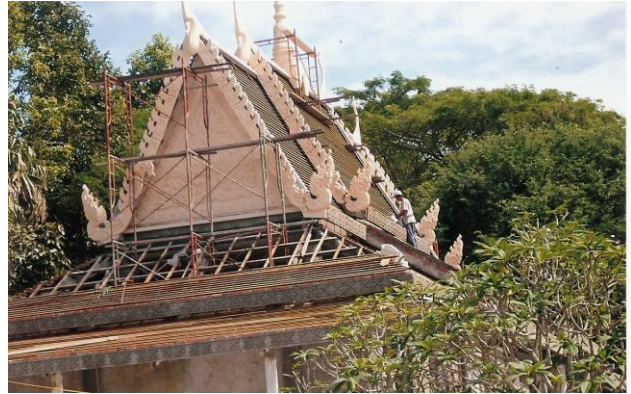
Ảnh 5: Chùa Dơi vừa bị hỏa hoạn đang được sửa chữa lại.
