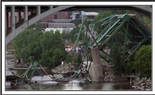
Cầu I-35W bị gãy và làm sập cầu
