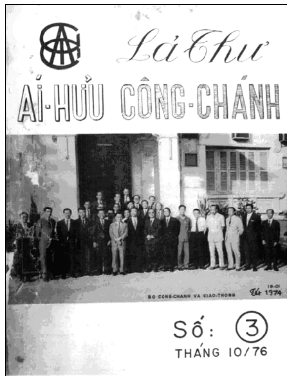
Bộ Công Chánh (1974)
