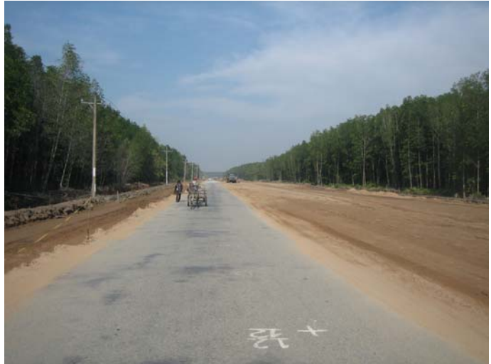
Rừng đước cao khoảng 10 mét và đường đang được mở rộng cả hai bên
