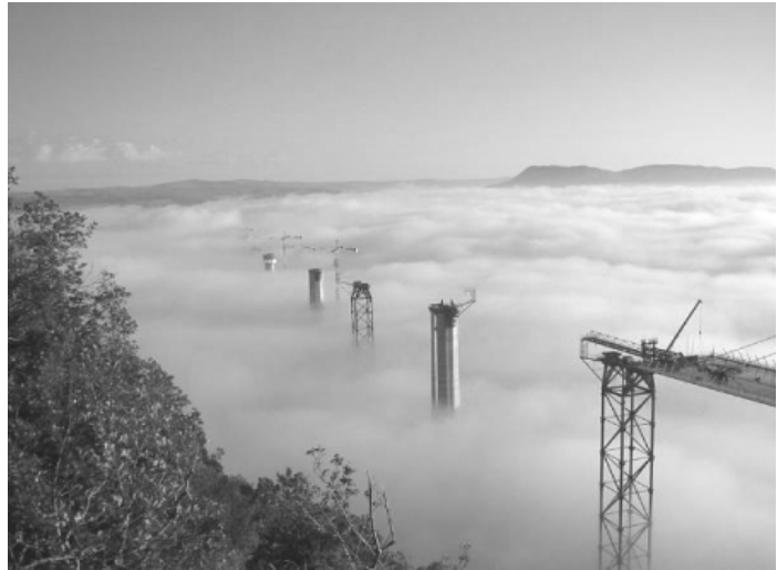
Cầu Millau trong giai đoạn xây cất
