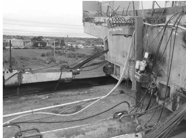
Hình 3. Cầu di chuyển do sức đẩy của hai con đội thủy lực
