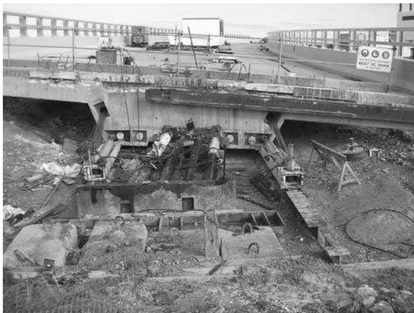
Hình 2. Ráp nối trên bờ hoàn thành
