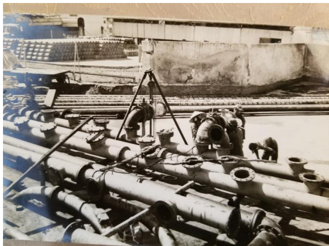
Hình một phần của dàn manifold đang được lắp ráp valves
