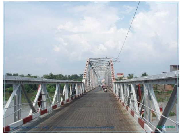
Cầu Phú Long (nhìn về phía Lái Thiêu)
