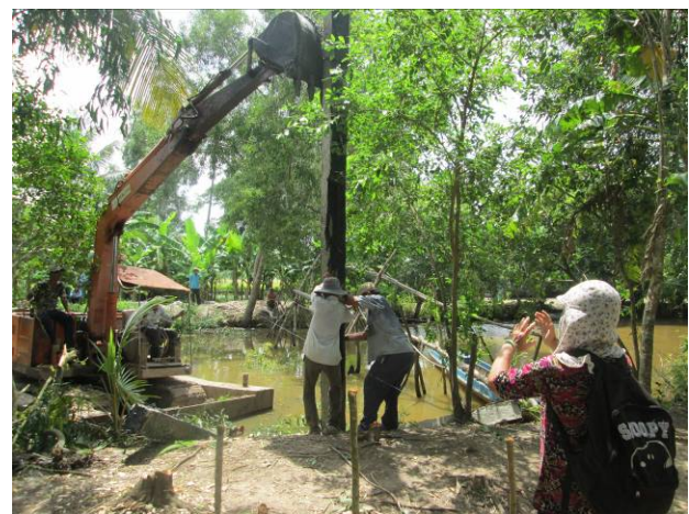
Công tác hạ cọc
