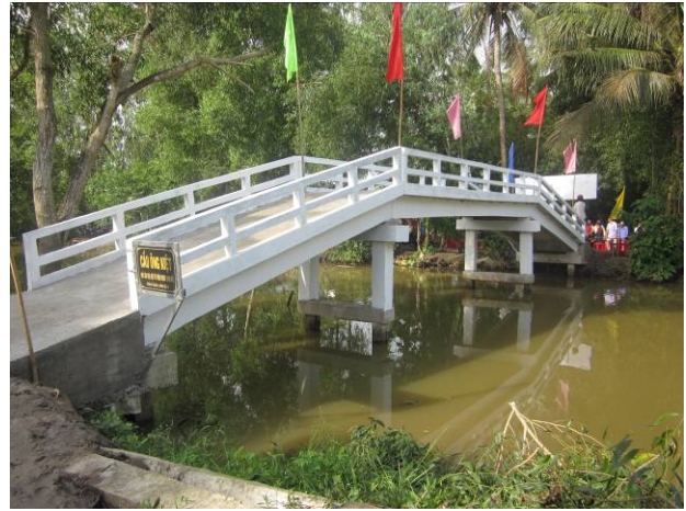
Hình ảnh cầu bê tông cốt thép mới xây
