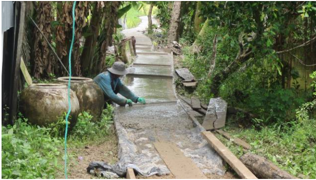
Công tác làm đường đan
