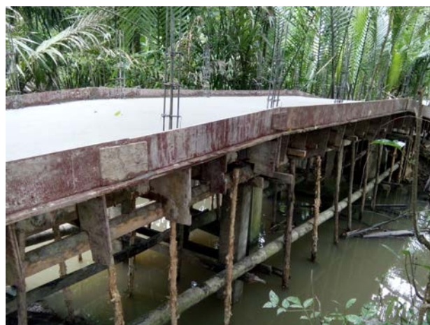
Đang thi công cầu
