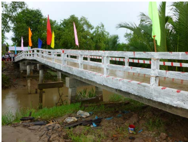
Cầu hoàn thành
