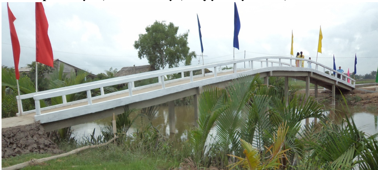
Cầu Xóm Chòi hoàn thành
