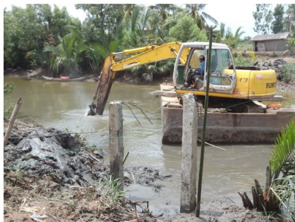
Hạ cọc cầu Xóm Chòi
