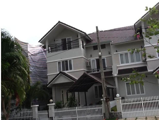
Nhà mặt tiền, nhà kế bên đang xây
